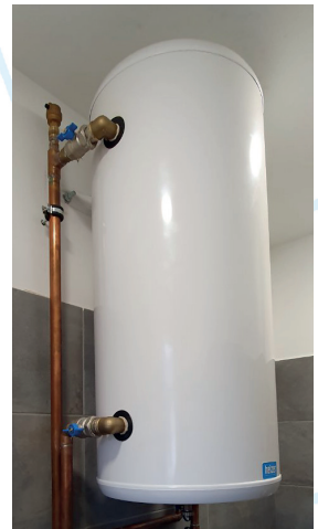
Rézcsővel csatlakoztatott melegvítartoló, hiányzik: tároló földelés és dielektromos közcsavar (plusz táglási tartály).
