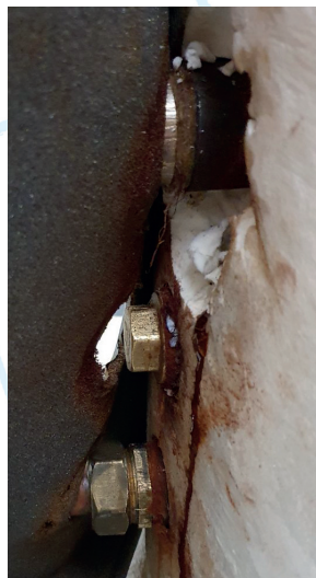
Rézcsővel „kötött” acéltartály csatlakozóinak elektrokémiai korróziója 16 hónap üzemeltetés után, a csatlakozók hegesztési varratainál már első üzeméven belül szivárgást okozhat.
